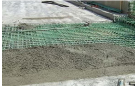
(b) Concrete Pour for Link Slab
