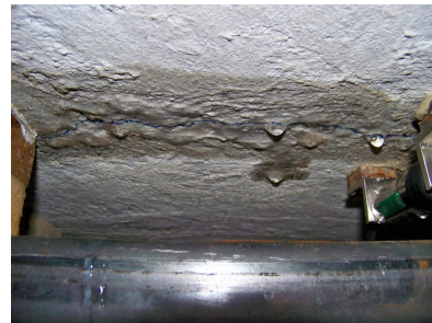
(d) Leakage From the Crack
